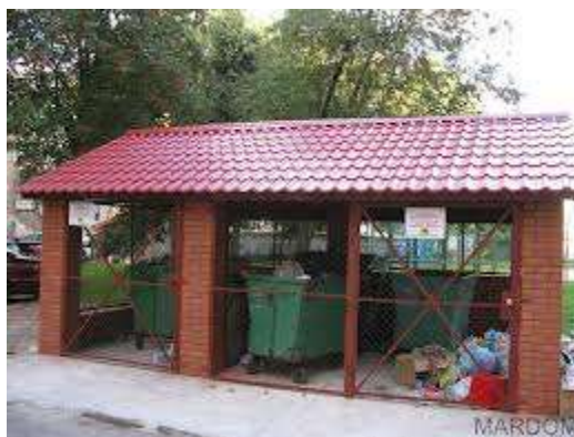
Przykładowa zamykana wiata z wydzielonymi boksami na poszczególne rodzaje pojemników na odpady.
